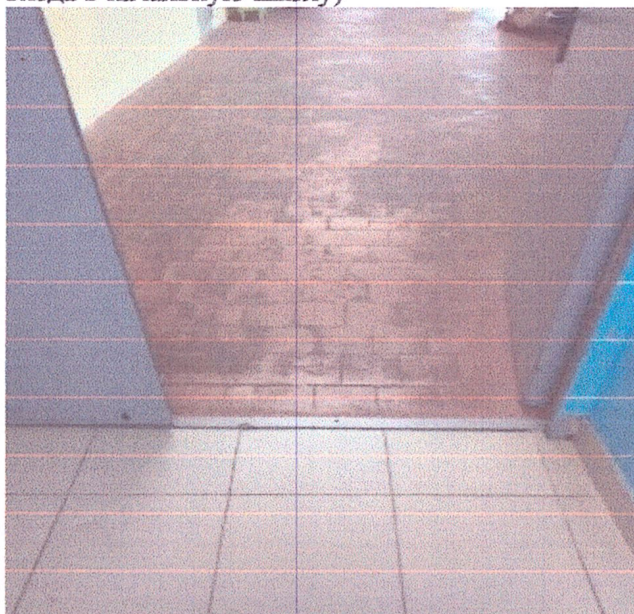
Фото № 14 Внутренняя дверь между холлом основной и начальной школой
