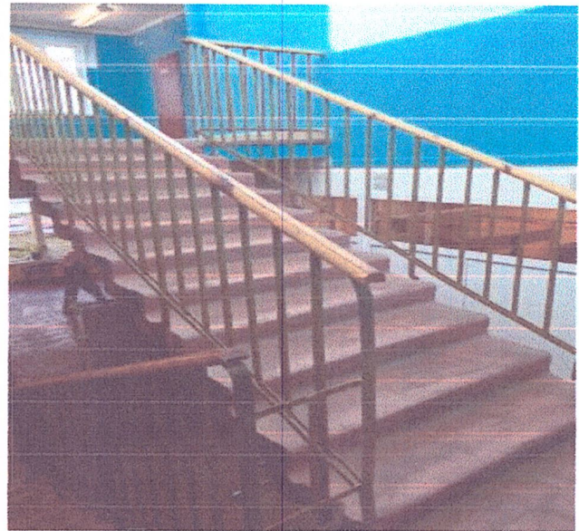
Фото № 20 Внутренняя лестница
